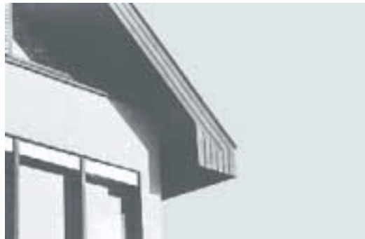
Falsch: zu massives Ortgesimse, bündig mit Dachfläche
