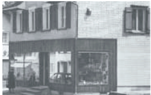
Ungünstig um die Ecke gezogene Fenster lassen das Gebäude optisch schweben. Falsche Materialwahl
