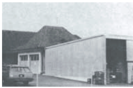
Ungünstig: Gestaltung des Anbaus ohne Rücksicht auf Altbau
