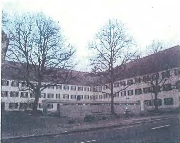
Abbildung 5: Die drei Platanen vor dem Seminar-gebäude.
